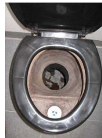
Vaso sanitário segregador de banheiro seco - Gana.
