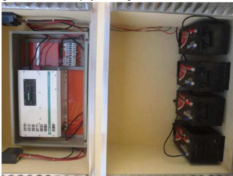
Baterias, inversores e demais sistemas das redes de captação de energia solar do CEADS da Vila Dois Rios
