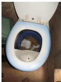
Vaso sanitário segregador de banheiro seco - Addis Ababa, Etiópia.
