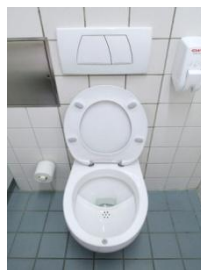
Vaso sanitário segregador a vácuo (1L/ fezes, 0,5L/ urina) - Roediger®, Suécia.
