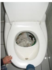
Vaso sanitário segregador de banheiro seco – prédio GIZ, Eschborn, Alemanha.
