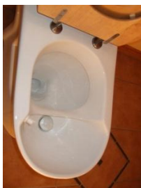
Vaso sanitário segregador a vácuo (1L/ fezes, 0,5L/ urina) - prédio GIZ, Eschborn, Alemanha.
