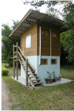
Banheiro seco implantado - CETRE.
